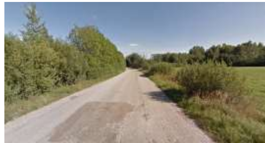
7.2. attēls. Transportēšanas ceļa posms
