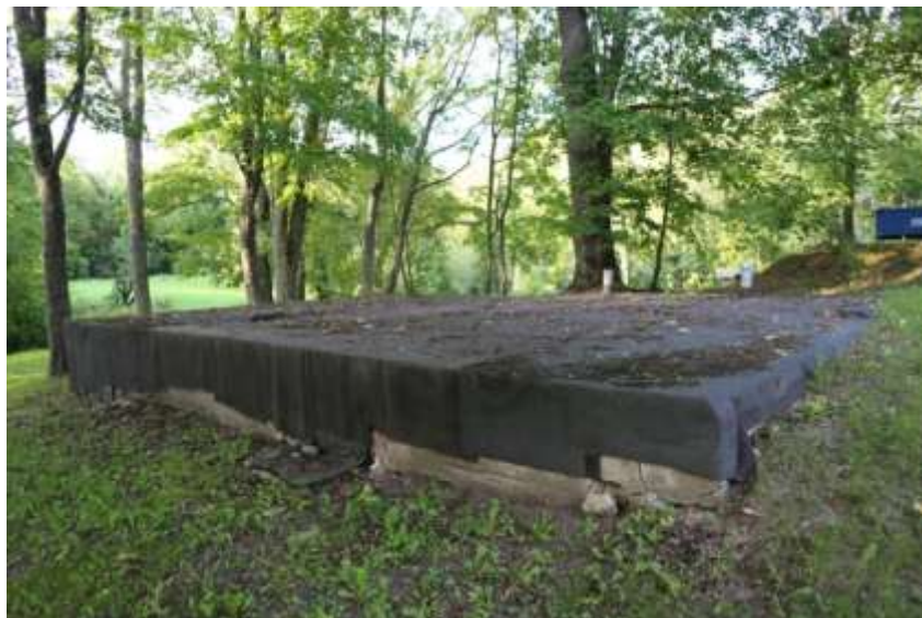
5.3.22. attēls. Ēkas pamati uz kuriem plānots izveidot āra klasi. Foto: M. Nitcis
