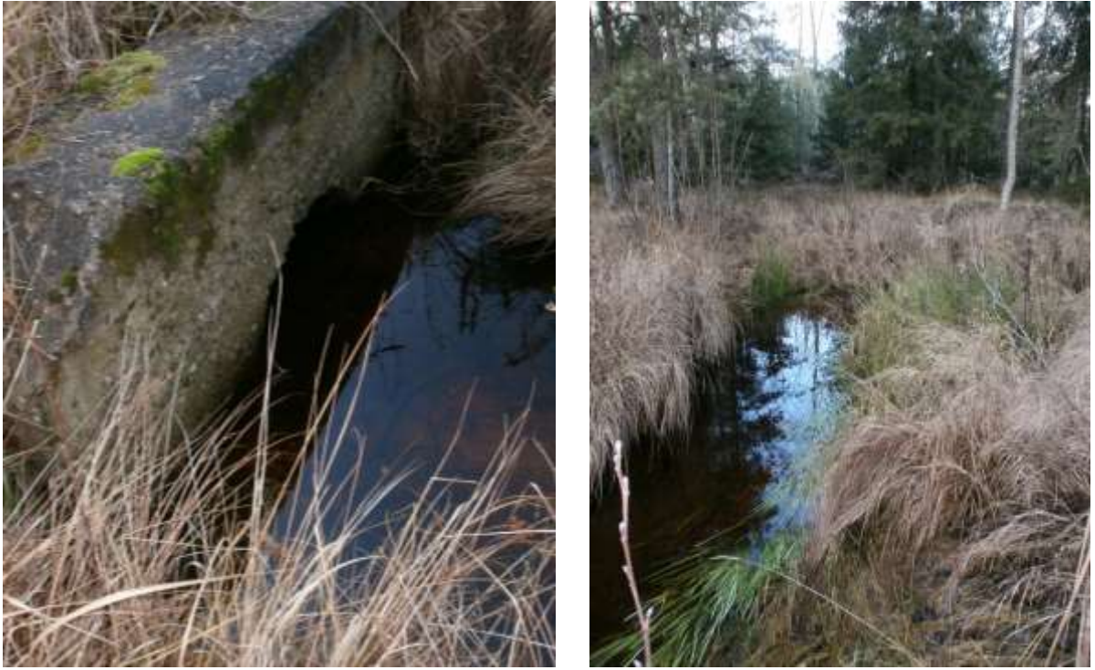
2.3.7. attēls. Caurteka NP-4 un grāvis augšpus caurtekas, kur novērojama aktīva ūdens plūsma. Foto: K. Vilciņa.
