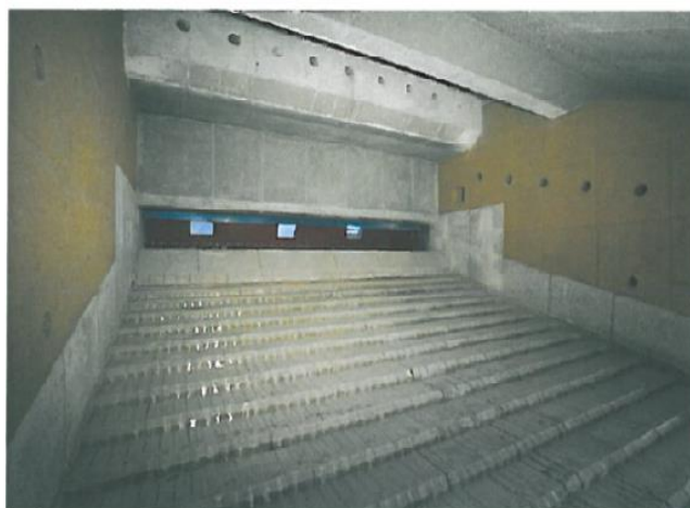
5.1. attēls. Kustīgo ārdū sadegšanas kameras piemērs 10
