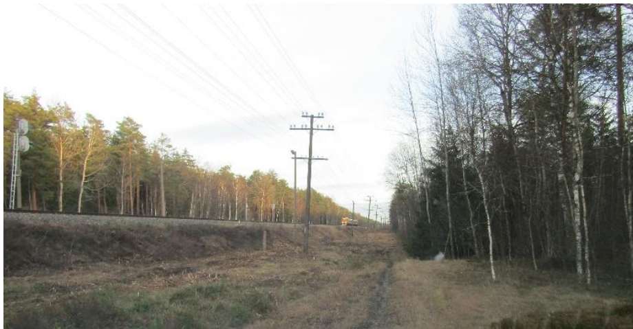
4.8.6. attēls. 2020. gadā no krūmiem atbrīvotā dzelzceļa stīga. Foto: A. Zacmanis.
