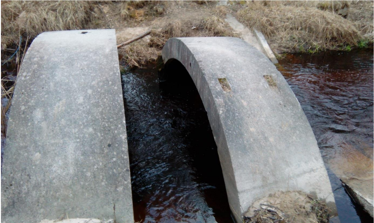
4.3.2.1. attēls. Dzelzsbetona konstrukcijas Krievupē 2019. gada 7 aprīlī. Foto: K. Vilciņa.
