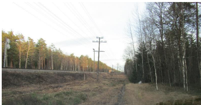
5. att. 2020. gadā no krūmiem atbrīvotā dzelzceļa stiga.
